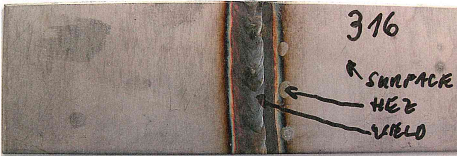
Bild 2: Zunder, Anlauffarben und Fe-Oxide haben die Passivschicht an der Schweißnaht zerstört.
