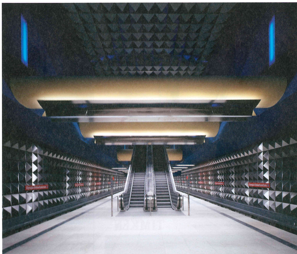
Edelstahl-Wandverkleidungen, Poliant-beschichtet zur Verbesserung der Reinigungsfähigkeit (easy-to-clean).
